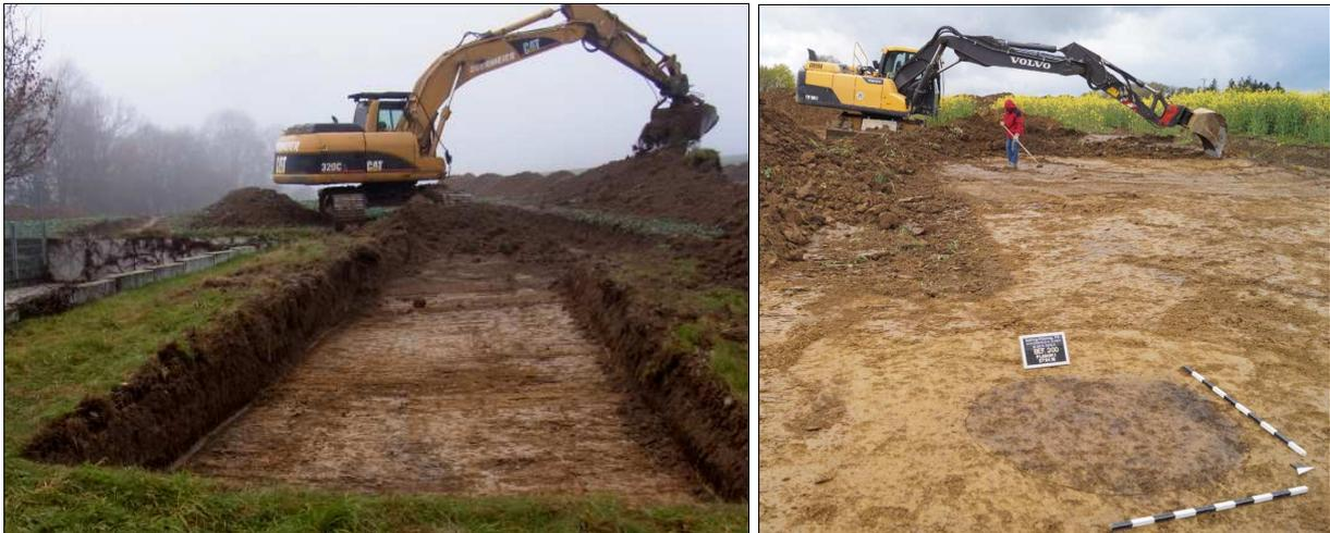
Abb. 7 Links: Oberbodenabtrag mit dem CAT-Kettenbagger. Rechts: Volvo-Mobilbagger.
